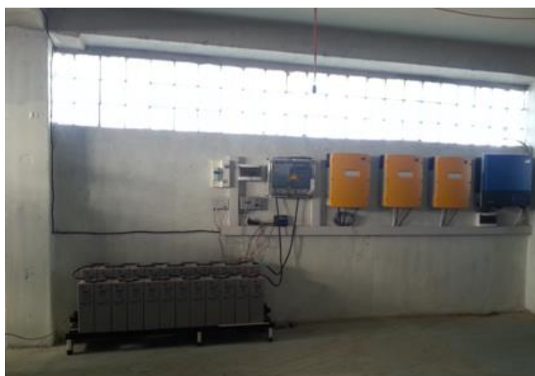
2- rasm. 20 kVt quvvatli FES energetik boshqaruv bloki va nazorat qurilmalari
