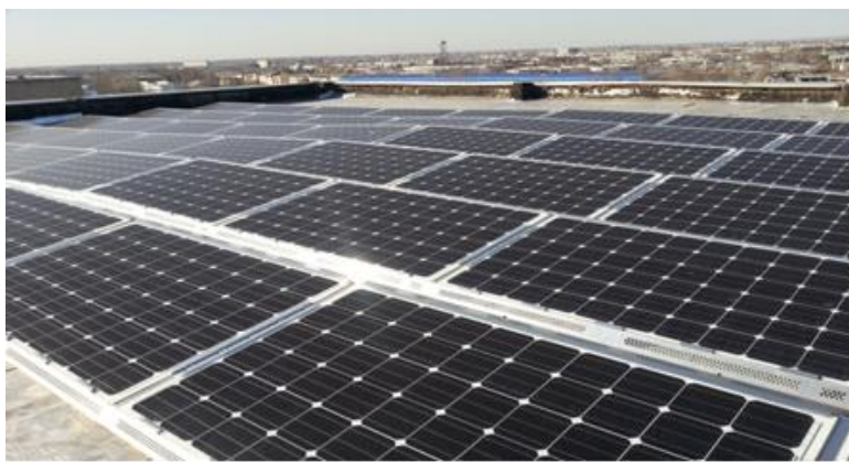
1-rasm. 20 kVt quvvatli quyosh fotoelektrik stansiyasining umumiy ko‘rinishi
