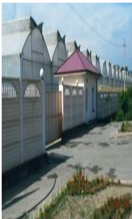
6–расм. 1-Зараркунанда иссиқхона ичига кириб қолмаслиги учун мўлжалланган иссиқхона кўриниши: 2 ва 3 – формугаларнинг капрон сетка билан ўралганлиги
