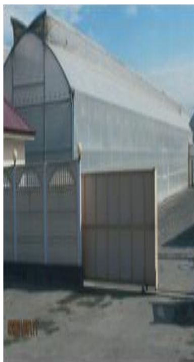
6–расм. 1-Зараркунанда иссиқхона ичига кириб қолмаслиги учун мўлжалланган иссиқхона кўриниши: 2 ва 3 – формугаларнинг капрон сетка билан ўралганлиги
