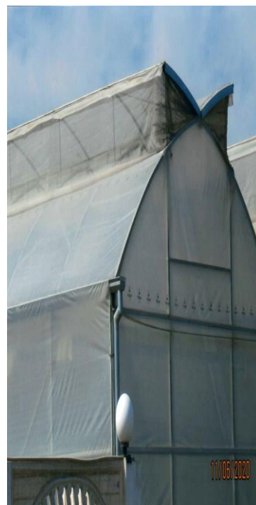
6–расм. 1-Зараркунанда иссиқхона ичига кириб қолмаслиги учун мўлжалланган иссиқхона кўриниши: 2 ва 3 – формугаларнинг капрон сетка билан ўралганлиги
