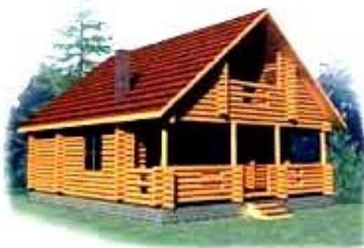
4-rasm. Gʻoʻla yogʻochli qurilish tizimida barpo etilgan bino.
