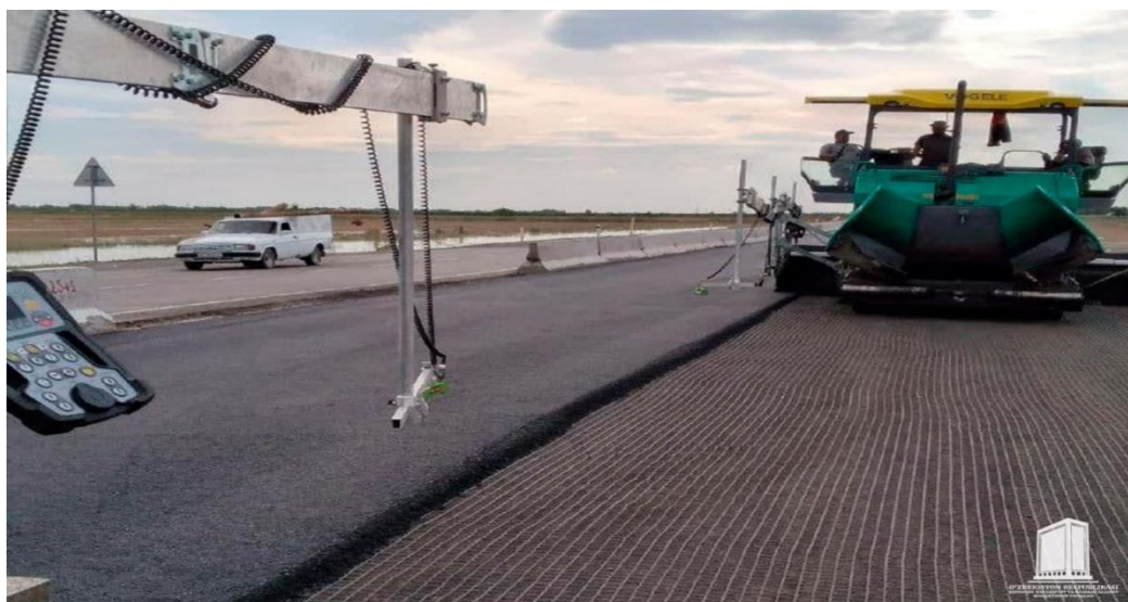
11.1-rasm. Asfaltbeton qoplamalar qurish jarayoni.
