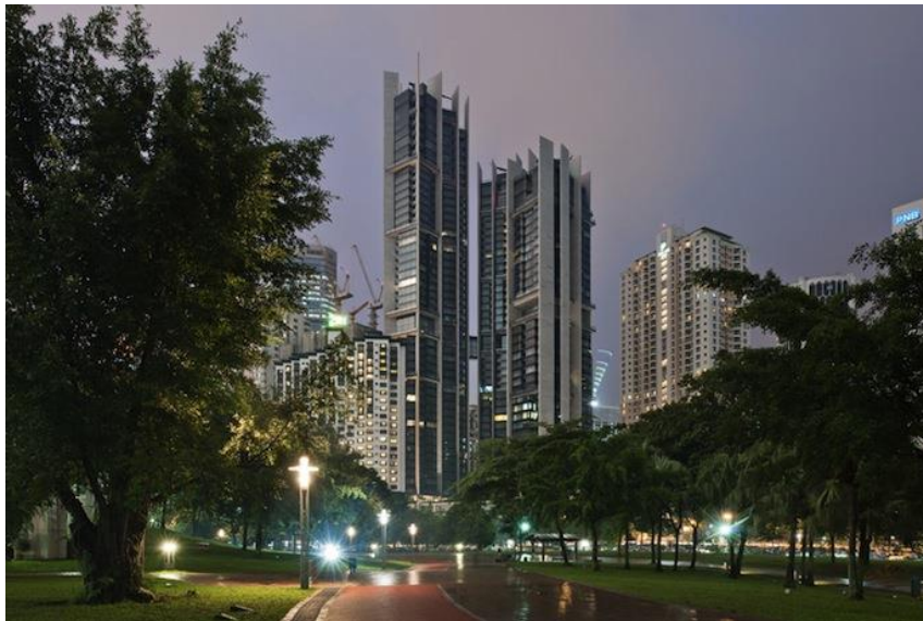
Рис. 1.21. Жилой комплекс «The Troika» архитектора Нормана Фостера. Общий вид.
