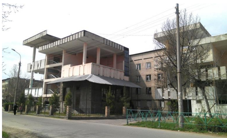
Рис. 1.33. Экспериментальный 4-х этажный жилой дом, с приквартирными дворами. Общий вид. (арх. Коробовцев Г.И., Х. Холилова ТашЗНИИЭП)
