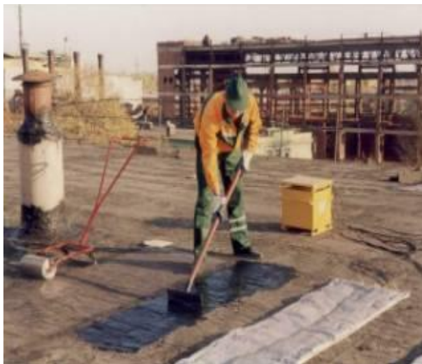
3.5- расм. Жамоат биносининг ўрама томқопламасини таъмирлашда “ПОТОК” қурилмалар жамланмасини (сувдан ҳимоялаш қатламини қиздириш, текислаш ва зичлашда) қўлланиши.
