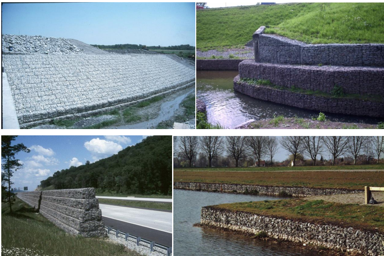
1.9-расм. Габион конструкцияларининг қўлланилиши.
