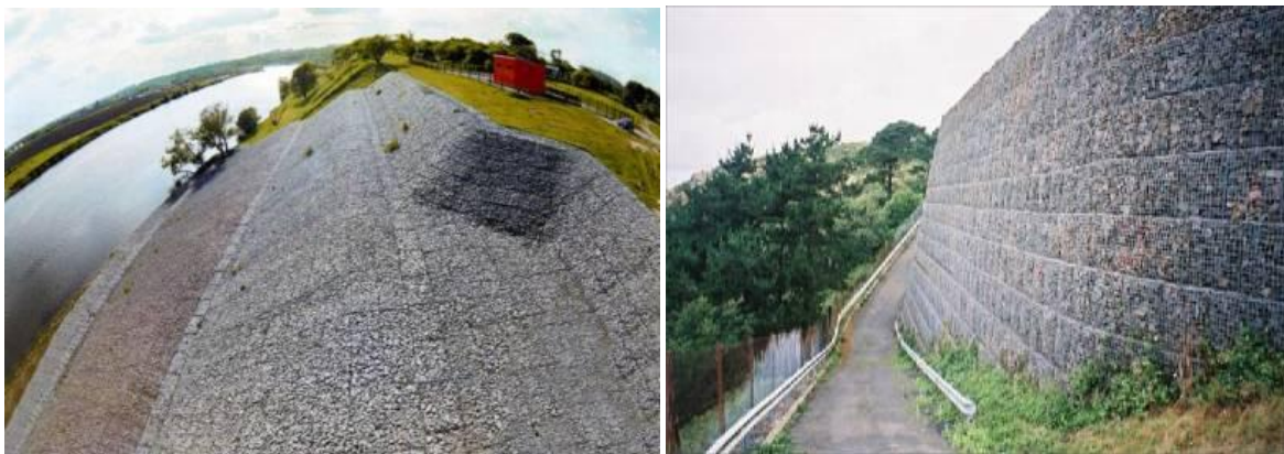
1.10-расм. Габион конструкциялари ёрдамида қияликларни мустаҳкамлаш
