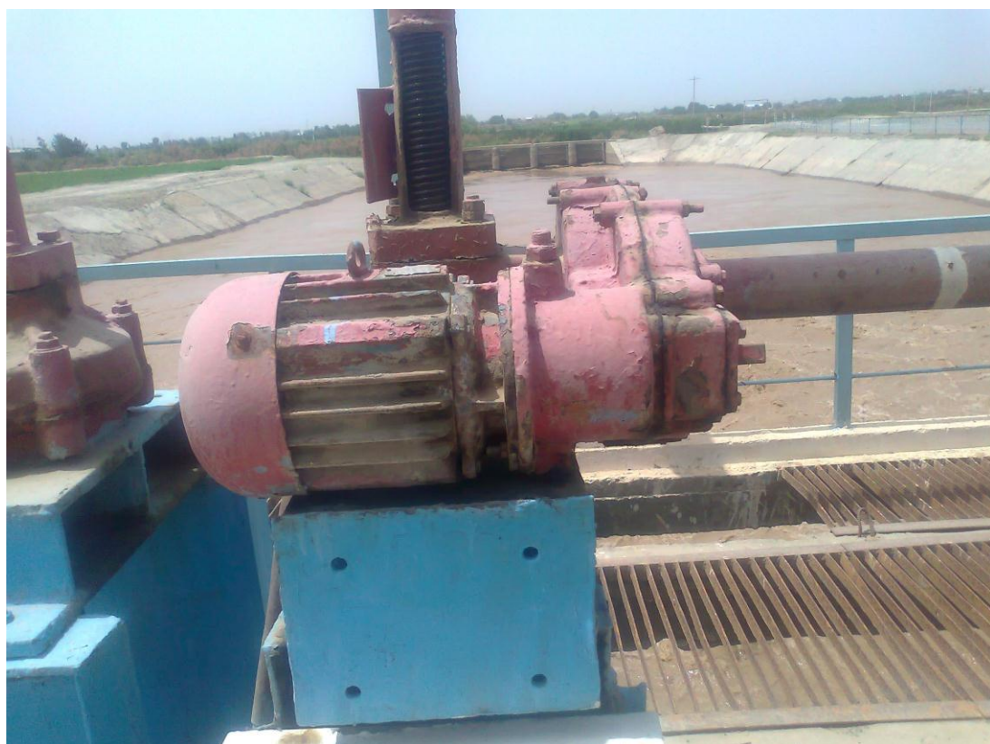
Хачкаб гидроузели затворларини кўтариб туширишнинг электрлаштирилганлик ҳолати.
