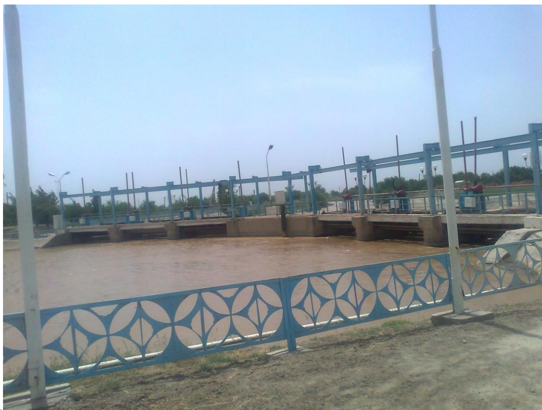
Хачкаб гидроузелининг сув ўтказиш затворлари (олд томондан кўриниши).
