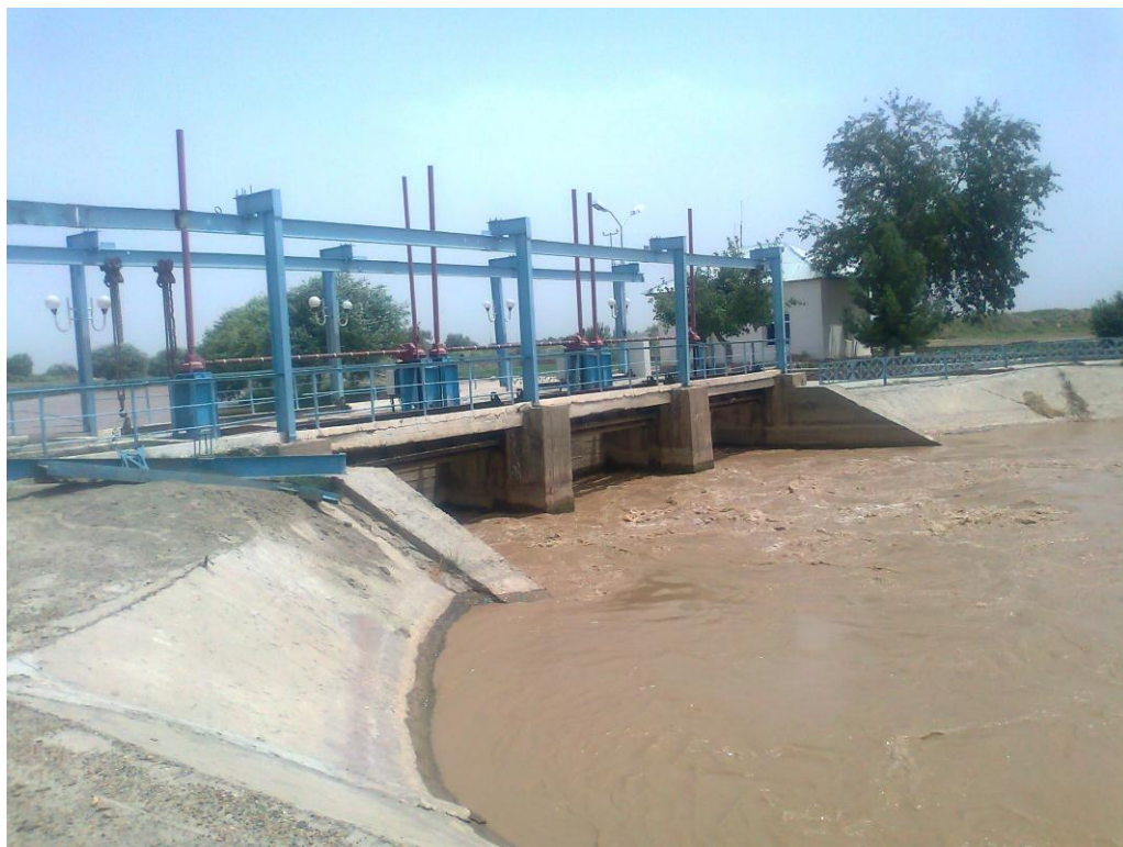
Хачкаб гидроузелининг Шохруд тармоғига сув ўтказиш затворлари(орка тарафдан кўриниши).
