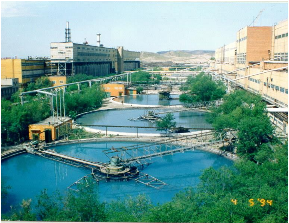
7.17.- rasm. NKMK GMZ-2 zavodning ko'inishi
