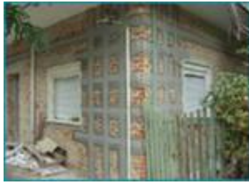
18- расм. Фарғона шаҳридаги турар-жой биносининг бурчак қисмини кучайтириш.
