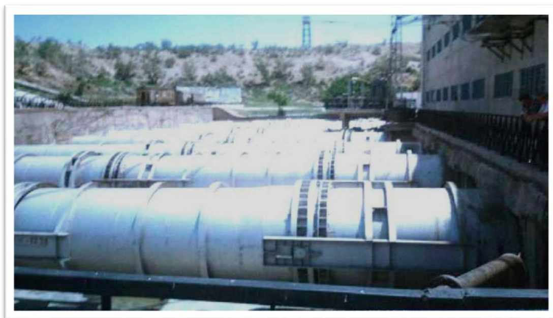
4-расм. Қизилтепа биринчи босқич насос станциясидаги Шофиркон ва Хар-хур каналларига сув ташловчи вертикал қувурларнинг жойлашуви.
