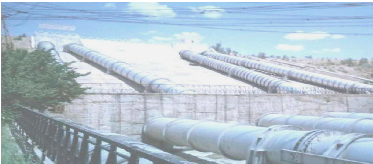
3-расм. Қизилтепа насос станциясидан чиқувчи сувни сув йиғиш камерасига ташловчи горизонтал сув ўтказгичларнинг жойлашуви
