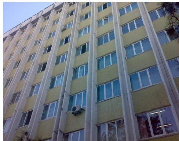
8-расм. Бинонинг бикрлик қовурғалари ўрнатилган қисми
