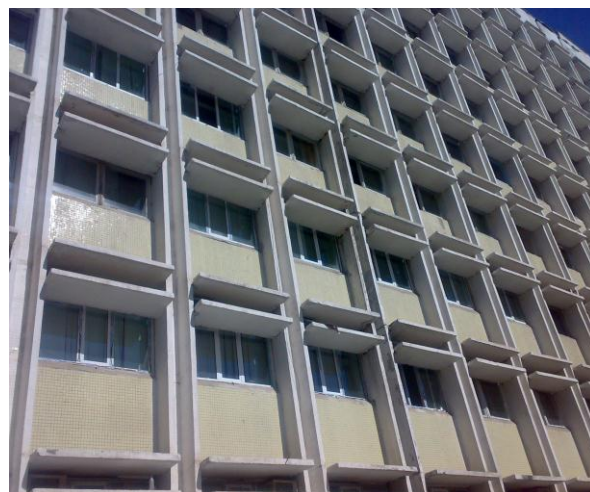
9-расм. Бинонинг бикрлик қовурғалари ва қуёшдан ҳимоя панеллари ўрнатилган қисми
