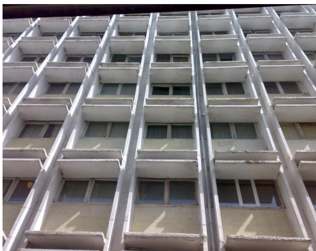
9-расм. Бинонинг бикрлик қовурғалари ва қуёшдан ҳимоя панеллари ўрнатилган қисми
