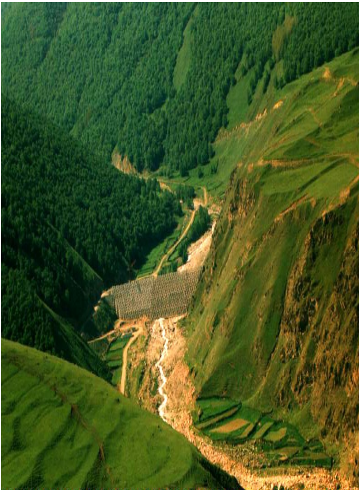
1- расм. Сел оқимларидан ҳимоялинида каркасли қурилмадан фойдаланиш
