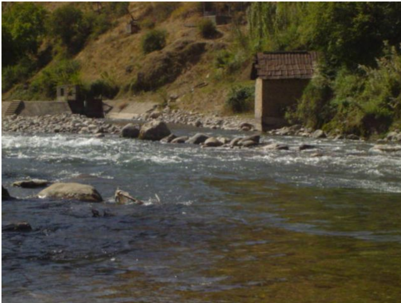
3.6-rasm. Ugam daryosidan Ugam kanaliga suv olishda toshdan bajarilgan suv ushlagich shporasi.
