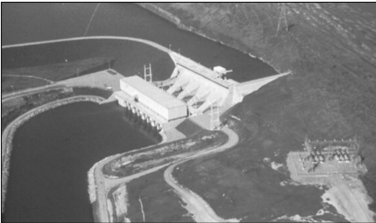
2.6- расм. Насос станциясининг кўриниши.
