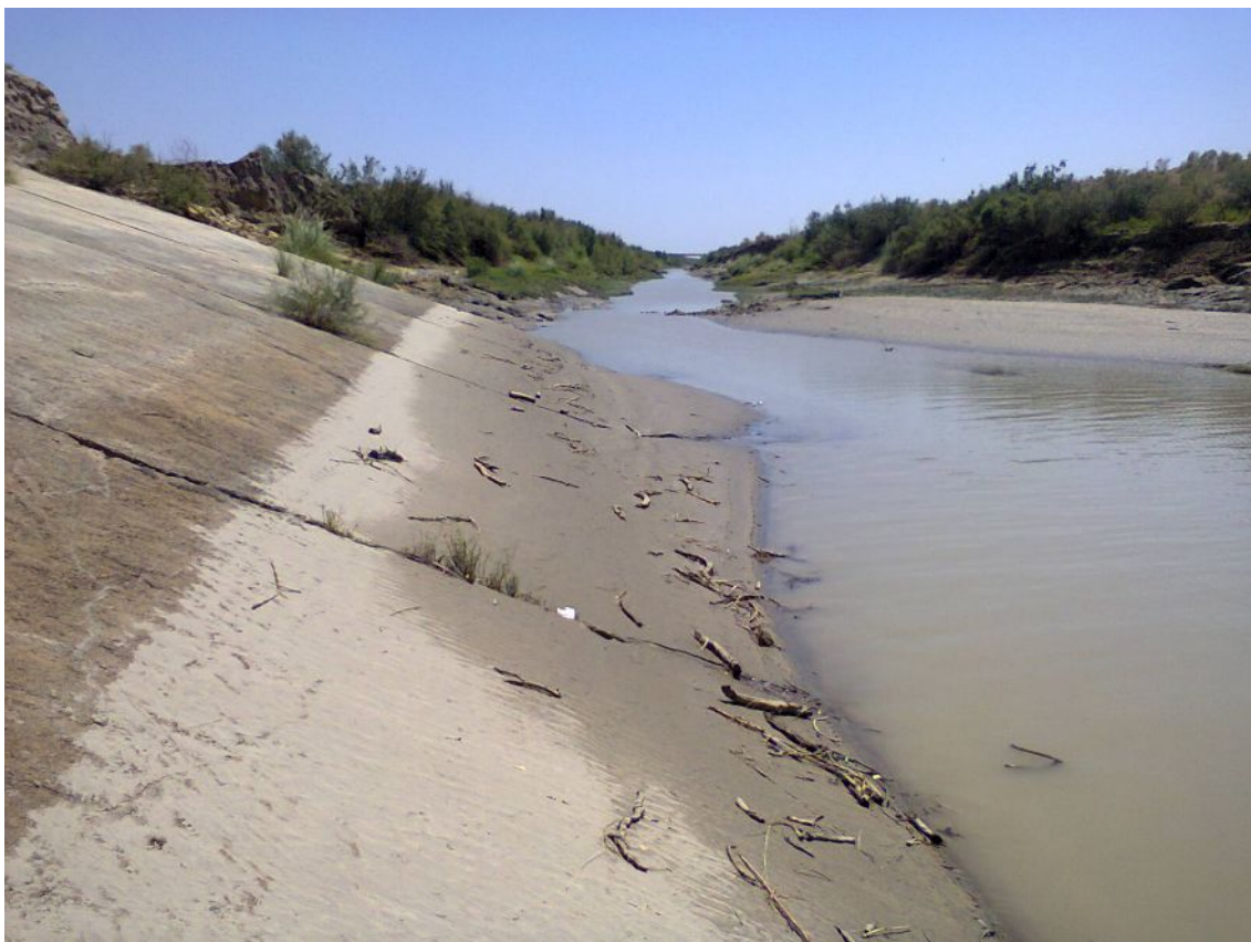
2.23-расм.Сув ташлама иншооти пастки бьефи ювилиши
