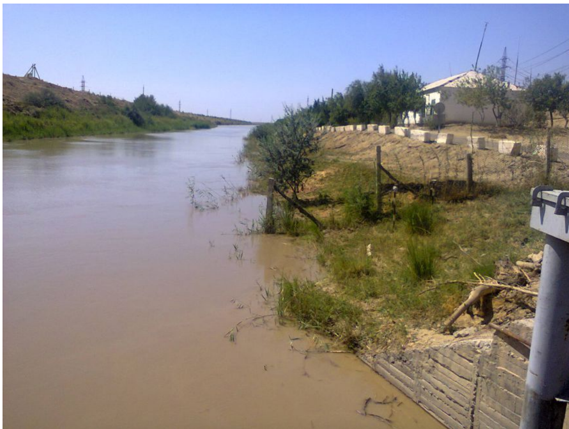
2.11-расм. Хамза-1 насос станцияси олдида лойқа ўтириши
