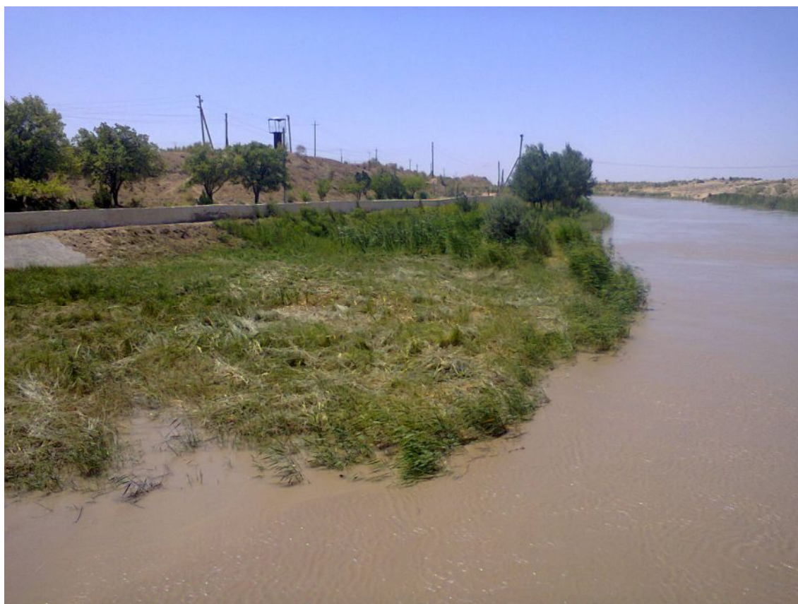
2.18-расм. Хамза-2 насос станцияси пастки бьефидаги лойқа чўкиш
