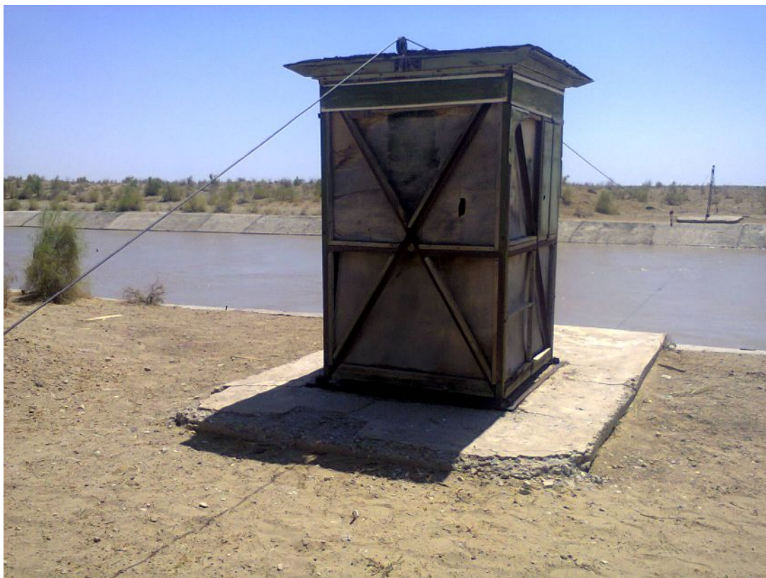
2.15-расм. Хамза-2 насос станцияси юқори бьефидаги сув ўлчаш гидропости (таъмирталаб)
