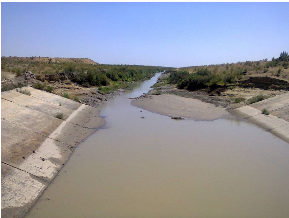
2.21-расм.Сув ташлама иншооти пастки бьефи ювилиши
