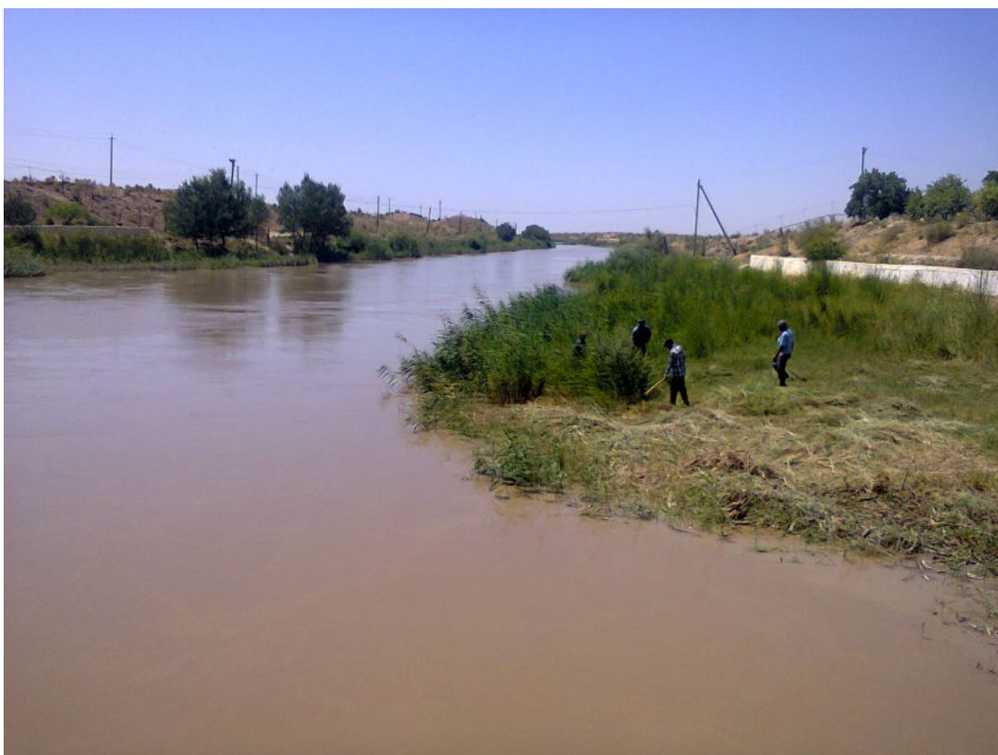
2.16-расм. Хамза-2 насос станцияси пастки бьефидаги лойқа чўкиш
