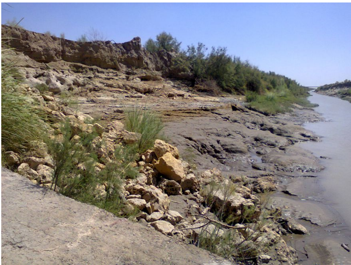
2.22-расм.Сув ташлама иншооти пастки бьефи ювилиши
