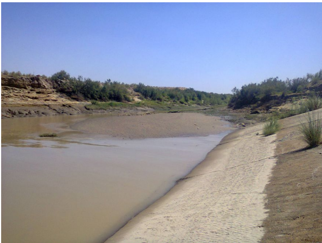
2.24-расм.Сув ташлама иншооти пастки бьефи ювилиши
