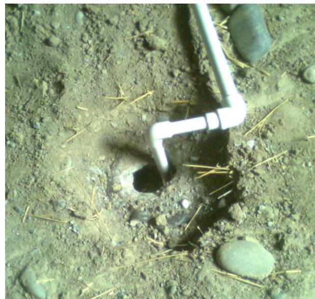
1 – расм. Том чордоқ қисмларида муҳандислик коммуникациялари қувурлари ўтказилганидан кейинги нуқсонлар.
