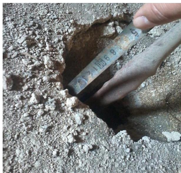
1 – расм. Том чордоқ қисмларида муҳандислик коммуникациялари қувурлари ўтказилганидан кейинги нуқсонлар.
