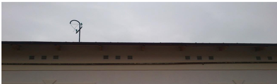
1-расм. Намунавий лойиҳалар асосида қурилган турар жой биносининг том қисми ташқи деворида шамоллатиш тешикларининг қўйилмаган ҳолати.
