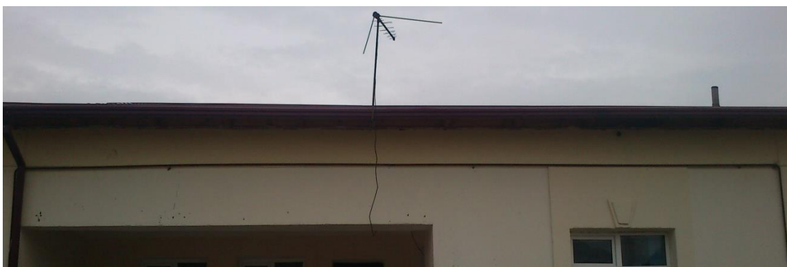
1-расм. Намунавий лойиҳалар асосида қурилган турар жой биносининг том қисми ташқи деворида шамоллатиш тешикларининг қўйилмаган ҳолати.
