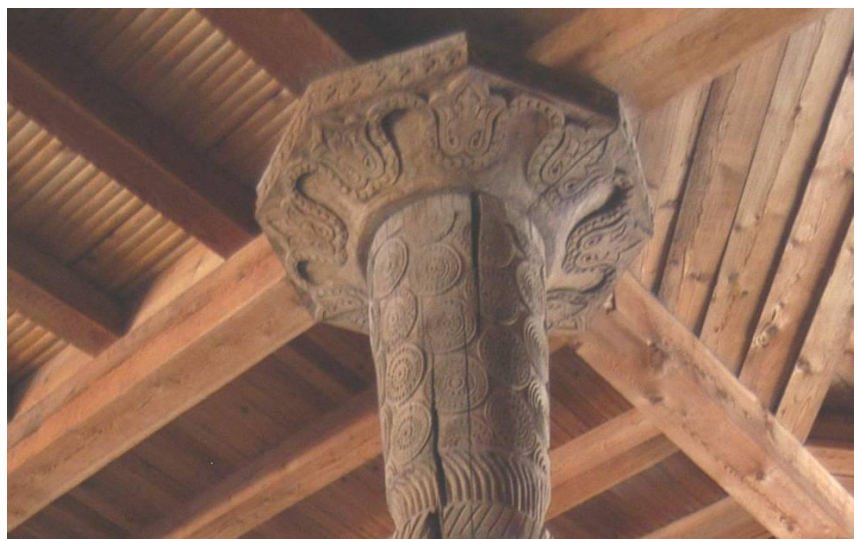
49-расм. “Жума Масжид” меъморий обидасининг шип ости қисми тўсинларининг ва устун “бошаси”нинг кўриниши
