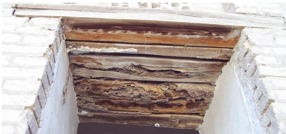
24-расм. Юсуф Ясовулбоши мадрасасининг эшик тепасининг ёғочларини термитдан зарарланиши
