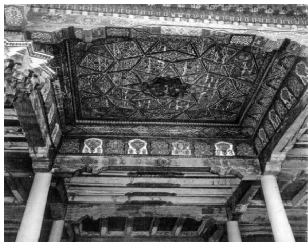
17-расм. Устунли-тўсинли шифт қурилмалари.
