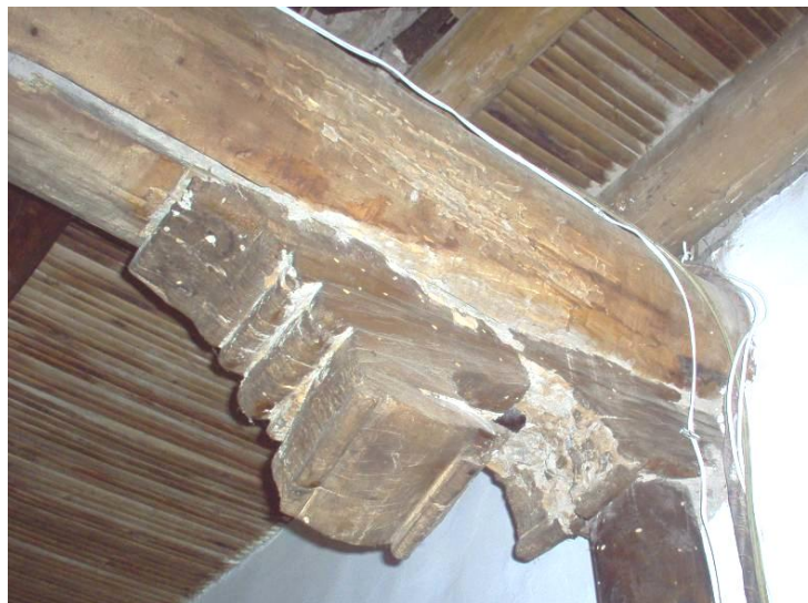
25-расм. Паҳлавон Маҳмуд мажмуасининг ошхонасидаги шип ёғочларининг термитдан зарарланганлиги
