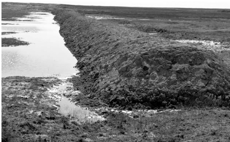
2.7-rasm. Botqoqlikda quvurlar tarmog'ini qisman chuqurlashish bilan yotqizish.
