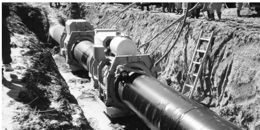
7.5.13-rasm. МГ gruntlash va МИАБ izolatsiyalash mashinalari ish paytida.
