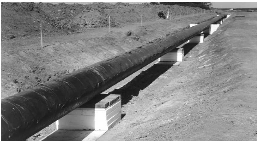
7.5.4-rasm. Quvurlar tarmog'i maksimal balandlikka ko'tarilgan.
