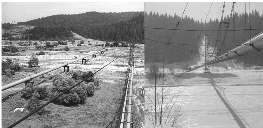
8.2.1-rasm. Gaz quvur tarmoqlarining yer usti o'tishlari: a) balkali, b) vintli.
