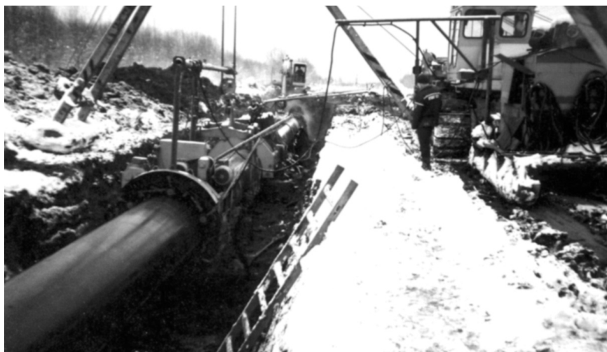
7.5.6-rasm. Izolatsiyani mexanik usulda tozalash.
