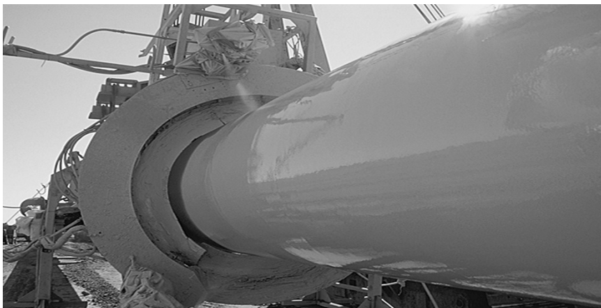
7.5.11-rasm. Avtomatik tarzda qoplash.
