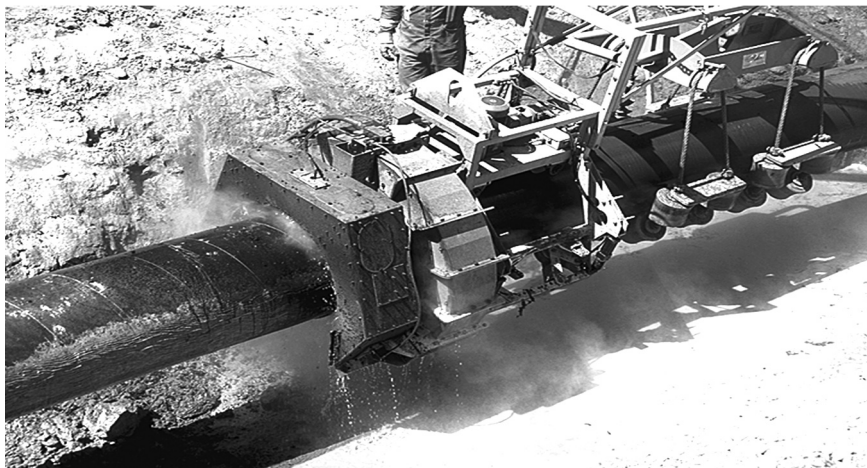
7.5.6-rasm. Izolatsiyani yuqori bosim ostidagi suv bilan tozalash.
