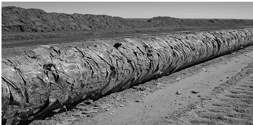
7.5.5-rasm. Plyonkali izolatsion qoplama.
