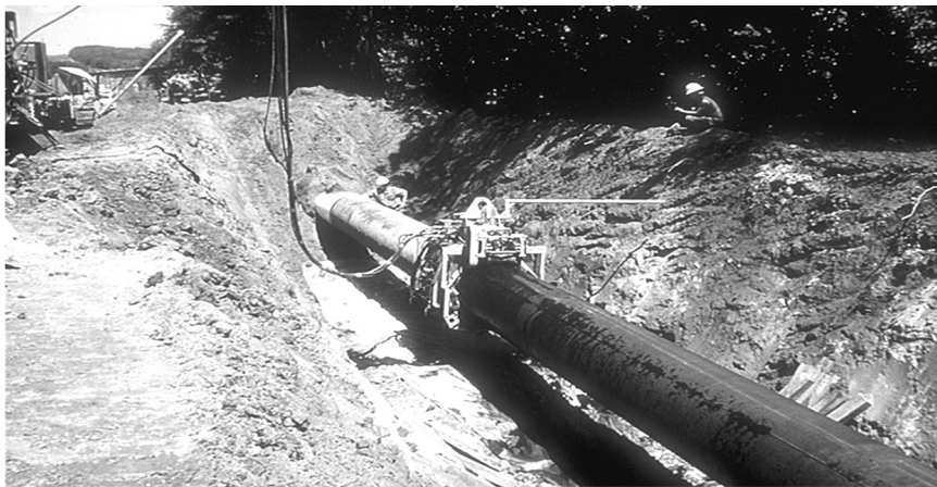
7.5.2-rasm. Amaldagi quvurlar tarmog'ini ta'mirlash.
