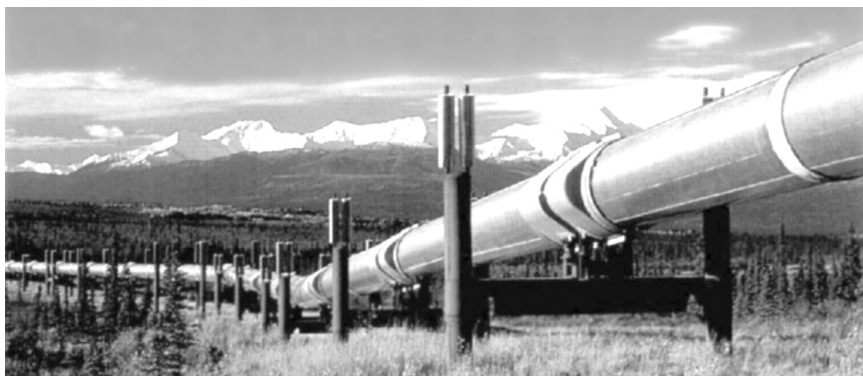
2.5-rasm. Magistral gaz quvurlari tarmoqlarini yer ustida yotqizish.
