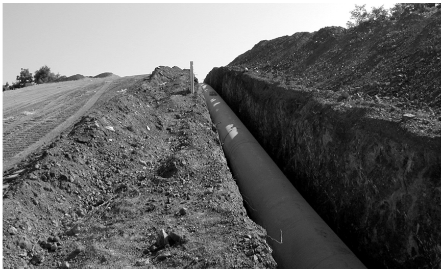
2.2-rasm. Gaz quvur tarmoqlarini yer ostidan o'tkazish.
