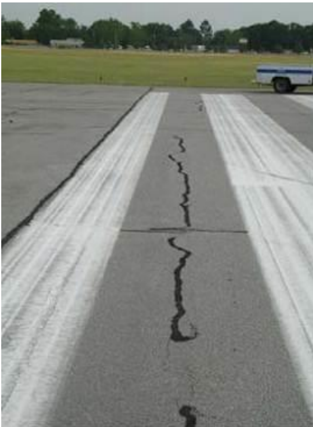
1.8-Rasm. Qoplamalardagi yoriqlar tasviri.
