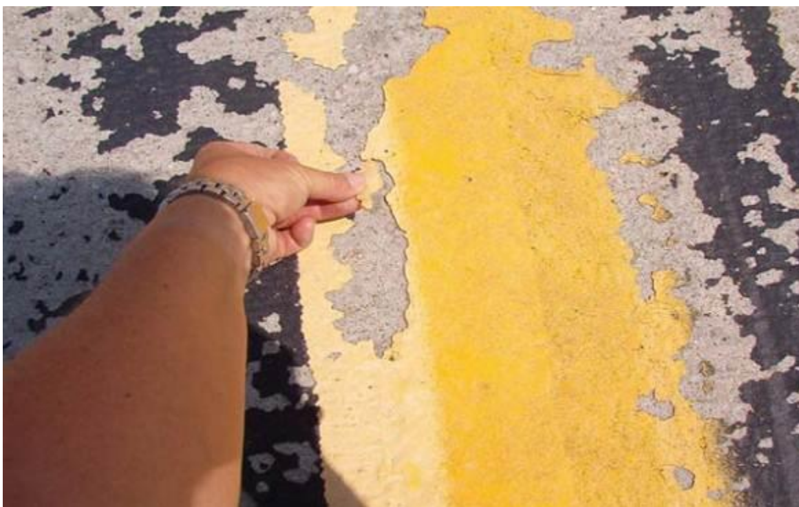
1.10-Rasm. Iqlimning Qoplama sirtiga ta'siri.
