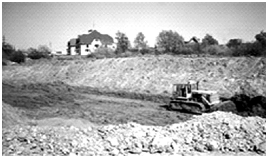
4-rasm. Ogʻir texnika vositalarida bogʻ-parklarda yer maydonlarini tayyorlash.
