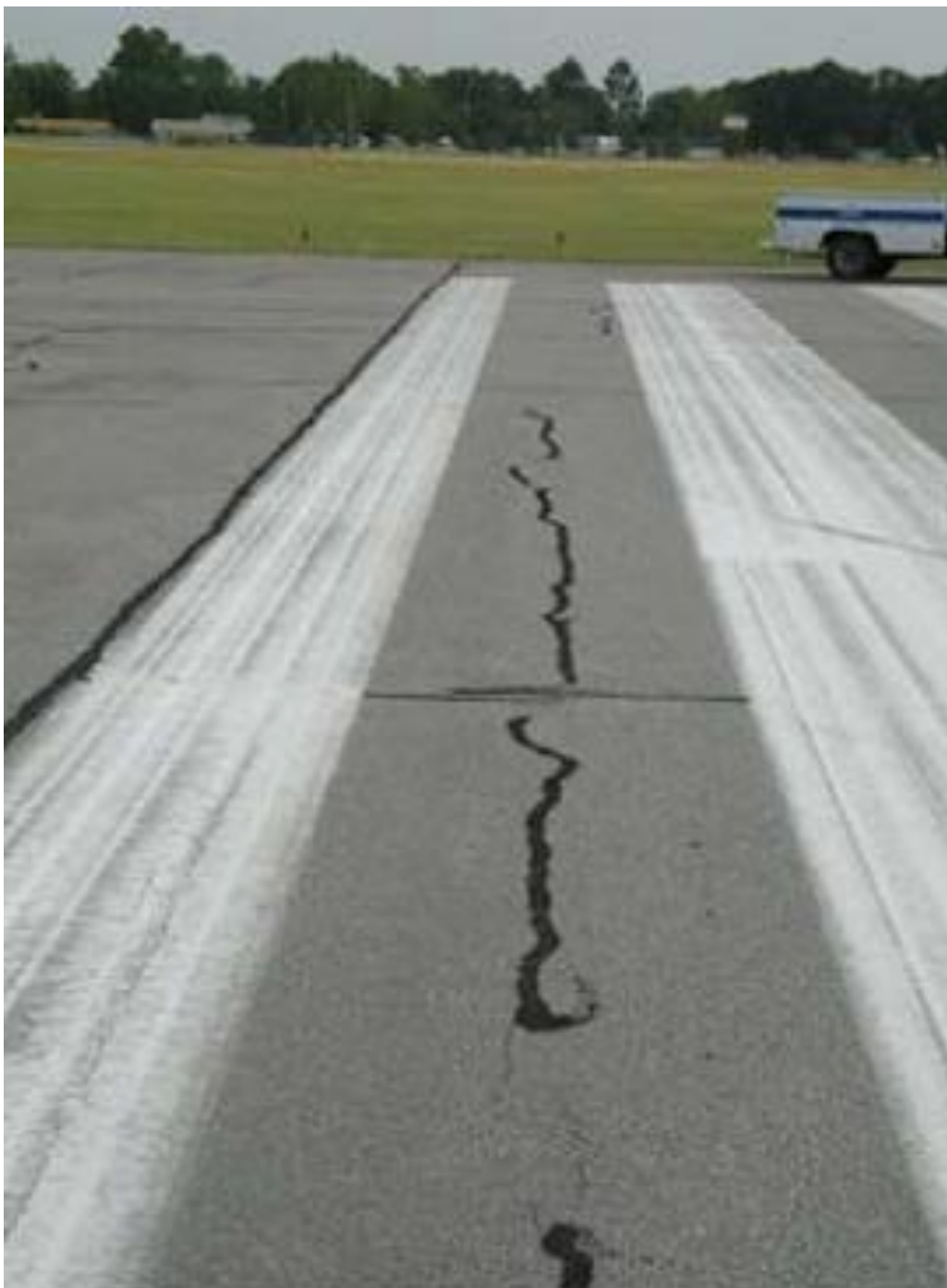
1.8-Rasm. Qoplamalardagi yoriqlar tasviri.
