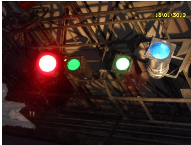
35-rasm. Portal ko'prigiga o'rnatilgan proyektorlar.(yoritgichlar).
