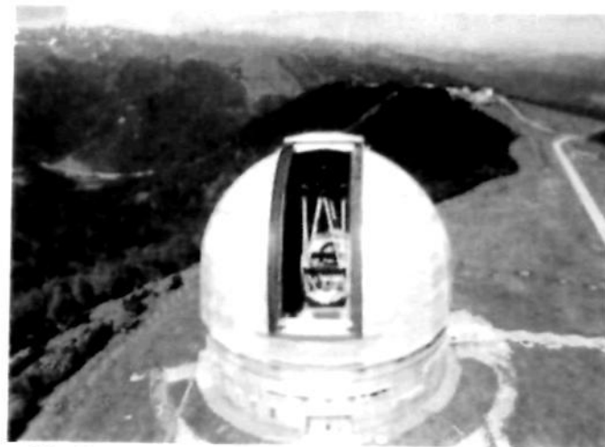
Рис. 56. Башня телескопа-рефлектора с диаметром зеркала 6 м, установленного на Северном Кавказе.
