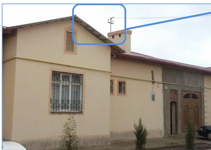
Рис.2.1. Ввод электрической сети жилого дома
