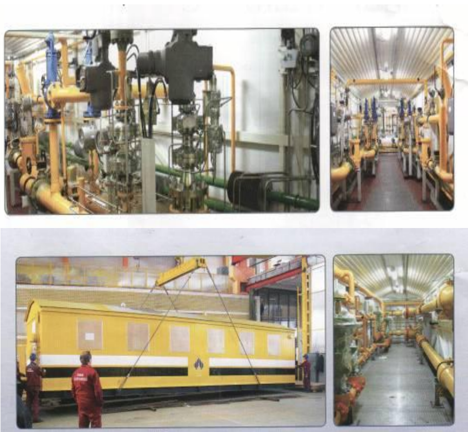
3.8-расм. ГРП одатда тақсимловчи тармоқларни газ билан таъминлайди
