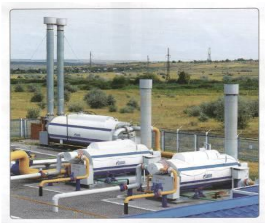
3.8-расм. ГРП одатда тақсимловчи тармоқларни газ билан таъминлайди
