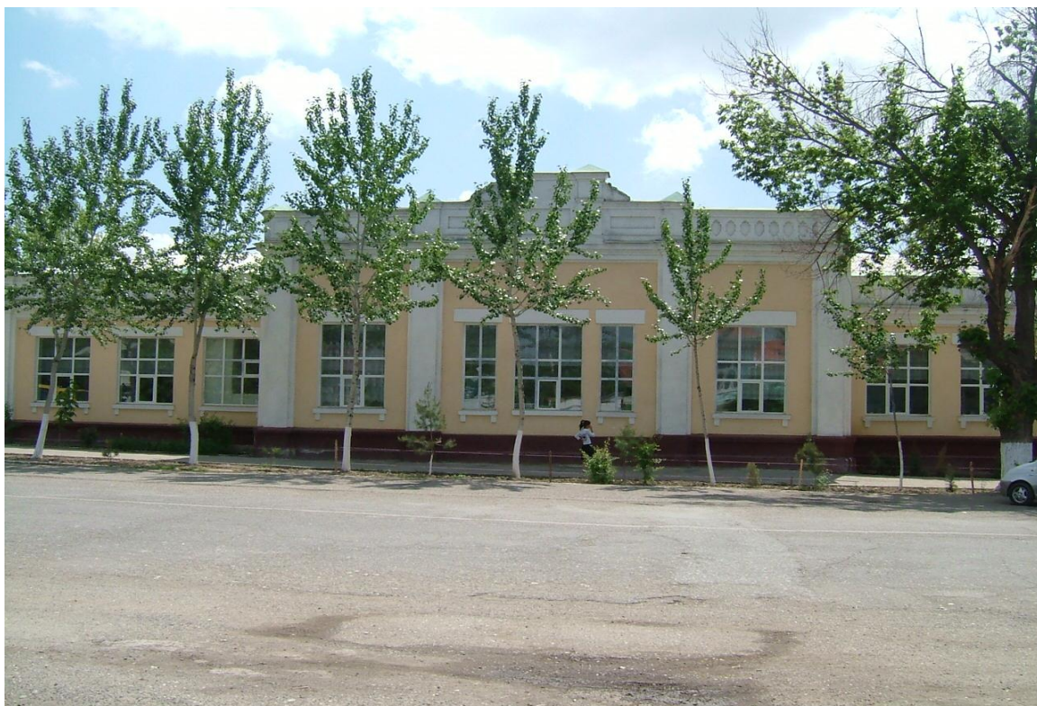
Здание построено в 1914г. Женская гимназия первой ступени, ныне школа №2
