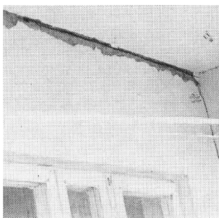
Йирик панелли бинода чокларнинг очилиши (Назарбек, 1980 йил 30 декабр)
