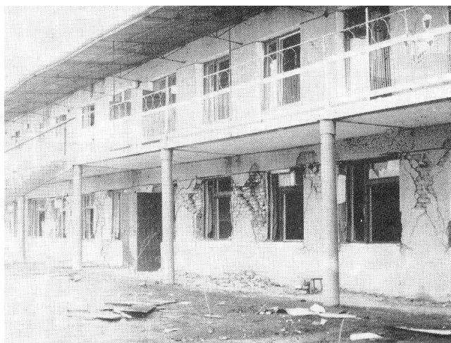
Болалар боғча биноси деворларининг шикастланиши (Газли, 1984 йил 20 март)
