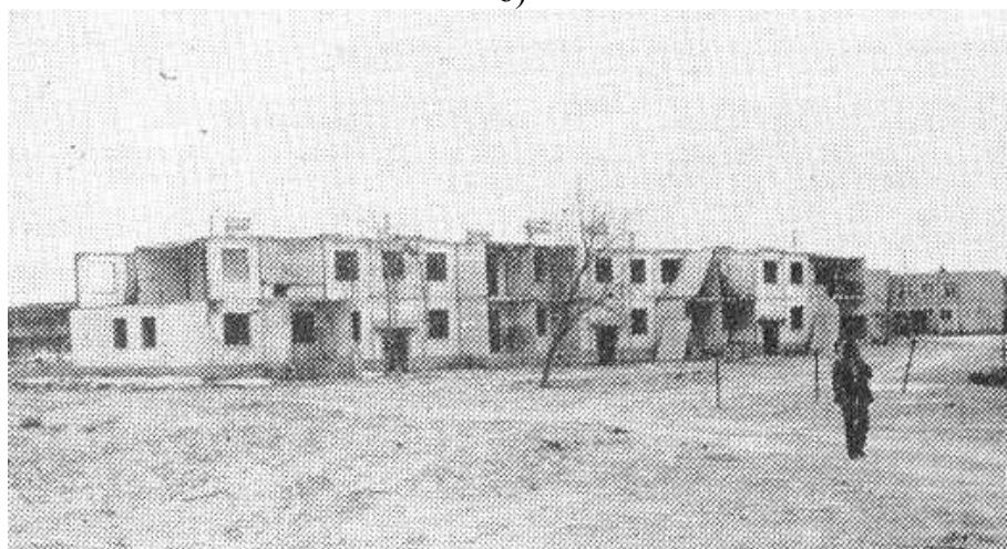
Кучайтирилган (а) ва кучайтирилмаган (б) йирик панелли уйнинг умумий кўриниши (Газли, 1984 йилги zilзиладан кейин)
