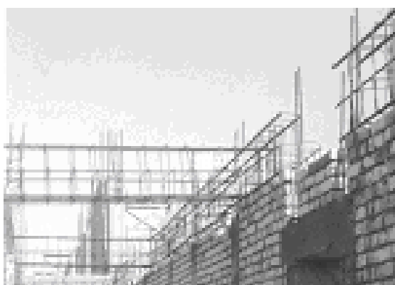
26-расм Антисейсмик камарнинг арматурали каркаси
