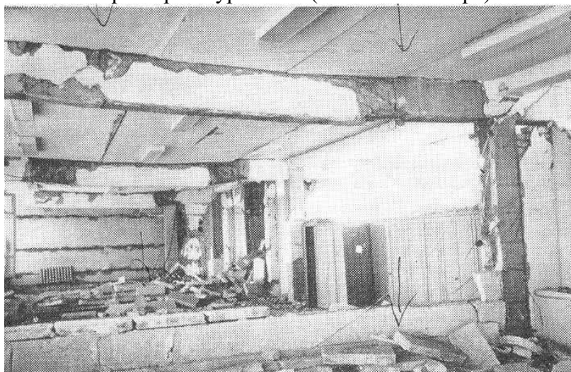
Бино девори простенкасининг шикастланишини характерли кўриниши (1984 йил 20 март)
