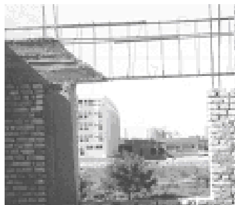
26-расм Антисейсмик камарнинг арматурали каркаси
