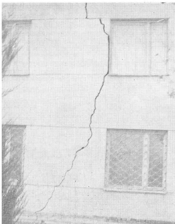
Пишиқ ғиштан тикланган бинода җосил бўлган ёриқлар (Назарбек, 1980 йил 11 декабр)
