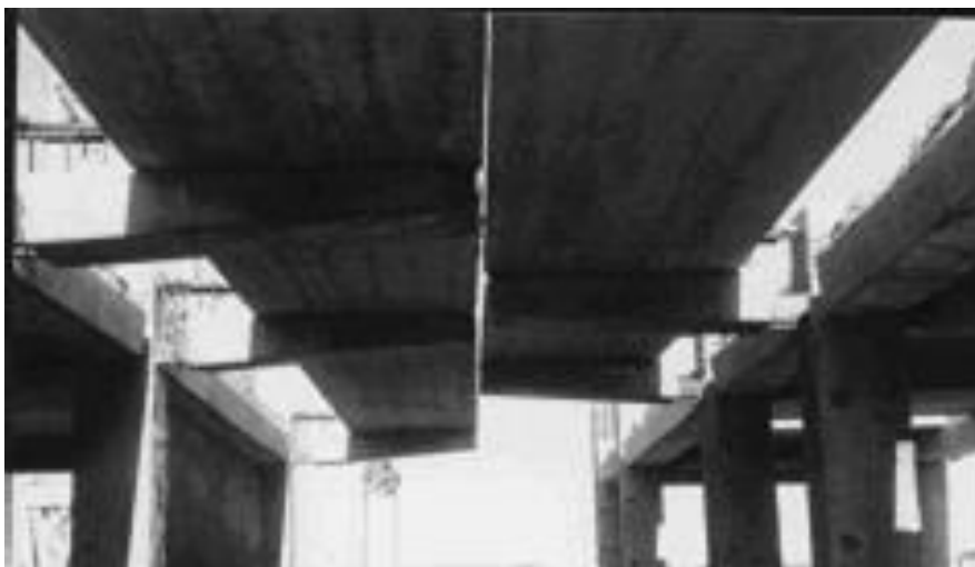
18-рasm Каркасли жамоат биносида қаватлар ёпмасы сатҳида қўйилган антисейсмик чок
