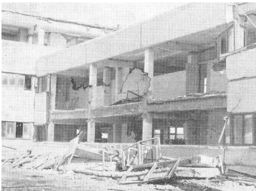
Каркас-панелли мактаб биноси ташқи девор панелларининг қулаб тушиши (Газли, 1984 йил 20 март)
