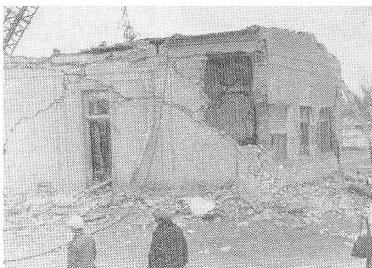
Канализация-насос станциясининг бузилиб кетиши ( Газли, 1984 йил 20 март)
