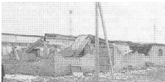
6-расм Омбор биноси деворлари ва ёпмаларининг қулаб кетиши ( Газли, 1984 йил 20 март)
