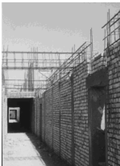
27- расм Вертикал темирбетон ўзакларнинг антисейсмик камарларга бириктирилиши
