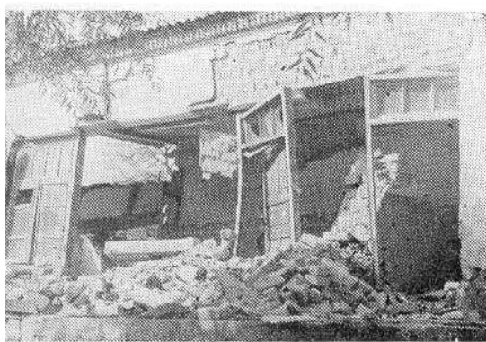
Антисейсмик темирбетон камар томонидан девор устки қисмининг қулашдан асраб қолиниши (Қайракум, 1985 йил 13 октябр)
