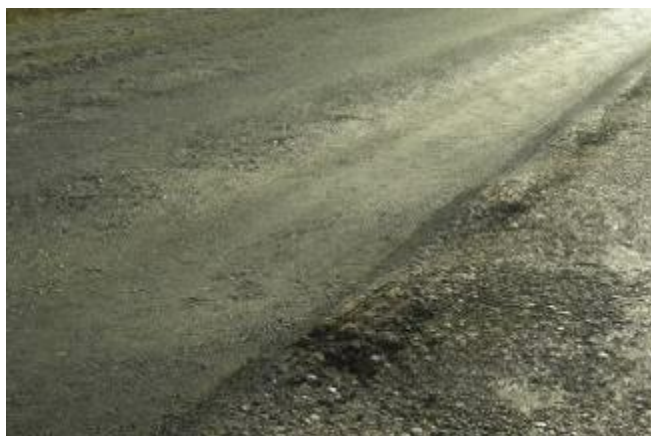
1-расм. Қопламада ботиқ изнинг кўриниши
