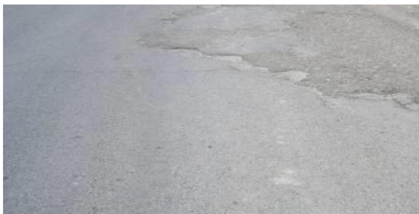
1-расм. Қопламада ботиқ изнинг кўриниши
