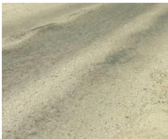
1-расм. Қопламада ботиқ изнинг кўриниши
