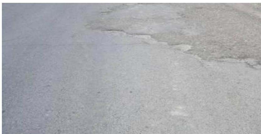
1-расм. Қопламада ботиқ изнинг кўриниши
