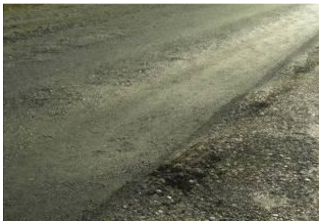
1-расм. Қопламада ботиқ изнинг кўриниши
