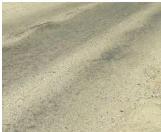
1-расм. Қопламада ботиқ изнинг кўриниши
