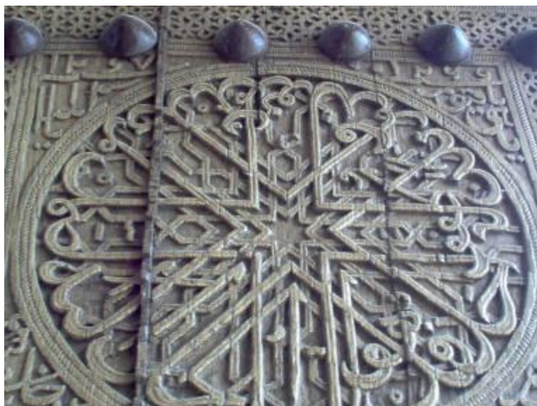
36-расм. Ичан-Қалъанинг “Ота Дарвоза” меъморий иншоотининг ёғоч ўймаkori эшиги ва ундаги маҳкамланган темир қозикларнинг умумий кўриниши
