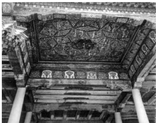
17-расм. Устунли-тўсинли шифт қурилмалари.
