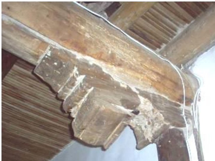
25-расм. Паҳлавон Маҳмуд мажмуасининг оиҳонасидаги шип ёғочларининг термитдан зарарланганлиги
