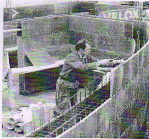
4- расм. «ВЕЛОКС» ёғоч-цементли плиталаридан опалубка сифатида фойдаланиш /10/.
