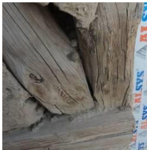
3.13-расм Стумгушанинг таксинчга бириктирилиши
