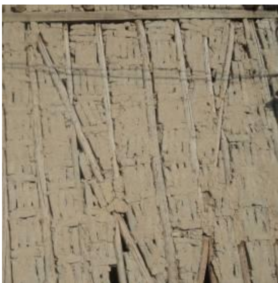
3.15-расм. Ҳавондаларнинг ўрнатилиши
