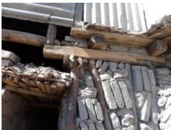
3.8- расм .Синч ёғоч элементлари орасини ғишт билан тўлдирилиши
