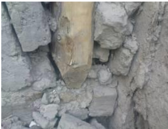
3.24-расм. Стумгушанинг таксинчга маҳкамланиши
