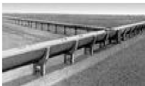
Рис. 2. Лотковые каналы оросительной сети.
