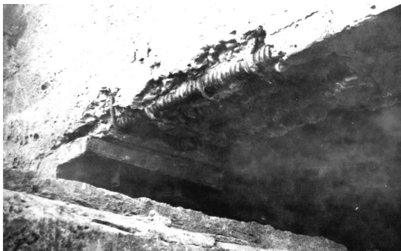
10–расм. Тангенциал таянч қисмлари асосининг силжиши ва тўсин арматурасининг очилиб қолиши
