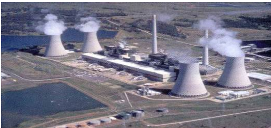
19-расм. Иссиқлик электростанцияси
