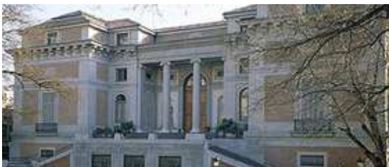
Acceso Norte. Puerta de Goya.
