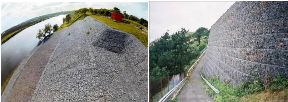
1.10-расм. Габион конструкциялари ёрдамида қияликларни мустаҳкамлаш
