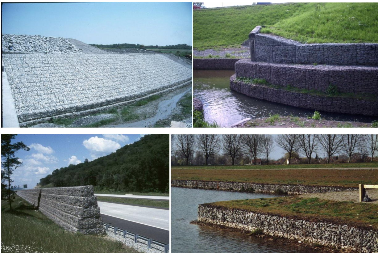
1.9-расм. Габион конструкцияларининг қўлланилиши.
