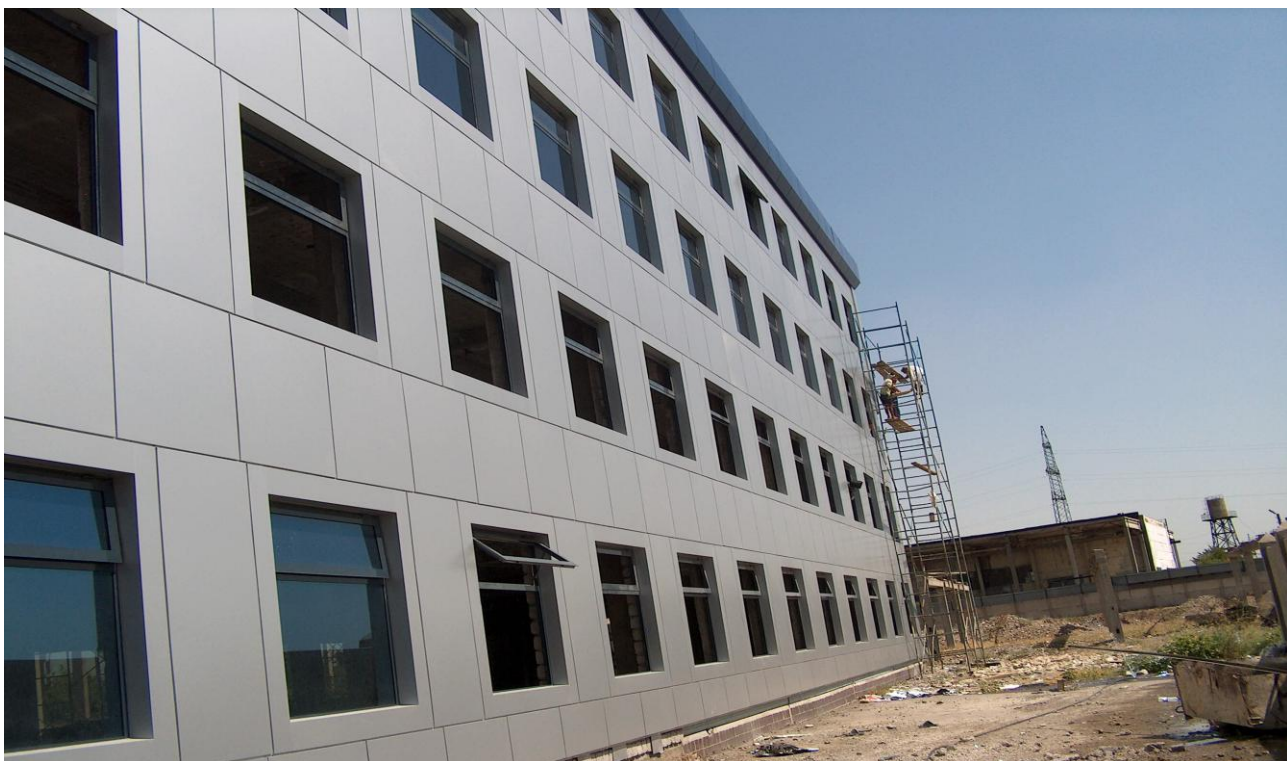
2-rasm. 4 qavatli ma'muriy binoning hozirgi holatidagi orqa fasadi ko'rinishi.
