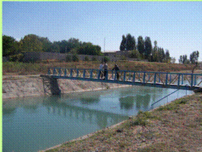
Паркент каналидаги гидропост
