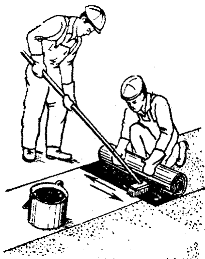
67-расм. Рубероидни том асосига ёпиштириш
