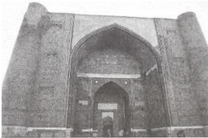
Bibixonim masjidi mehrobli binosining restavratsiya davridagi holati
