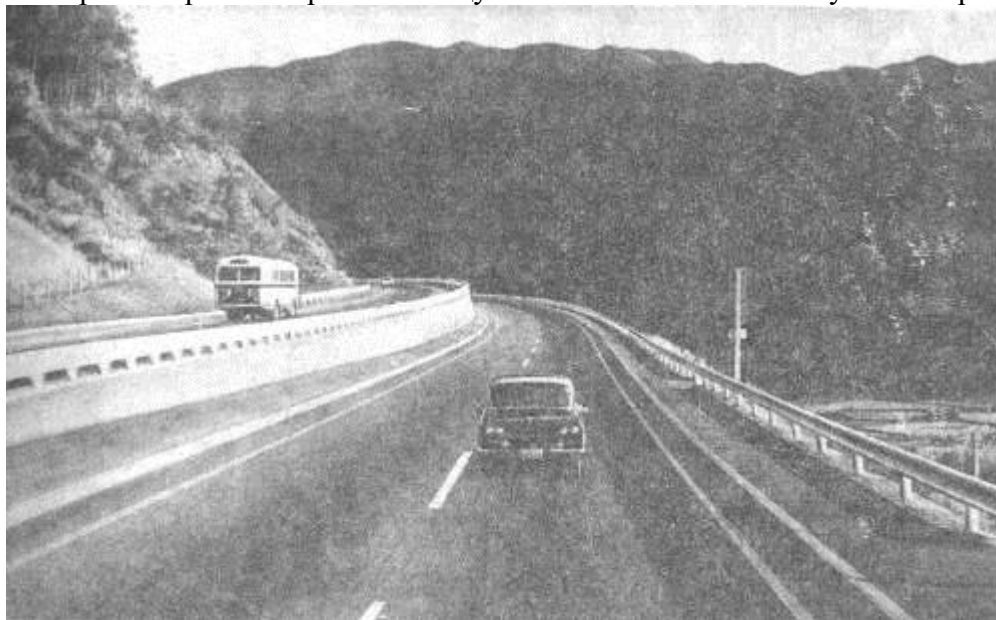
6- расм. Қияламада қатнов қисмларининг поғонали жойлаштирилиши
