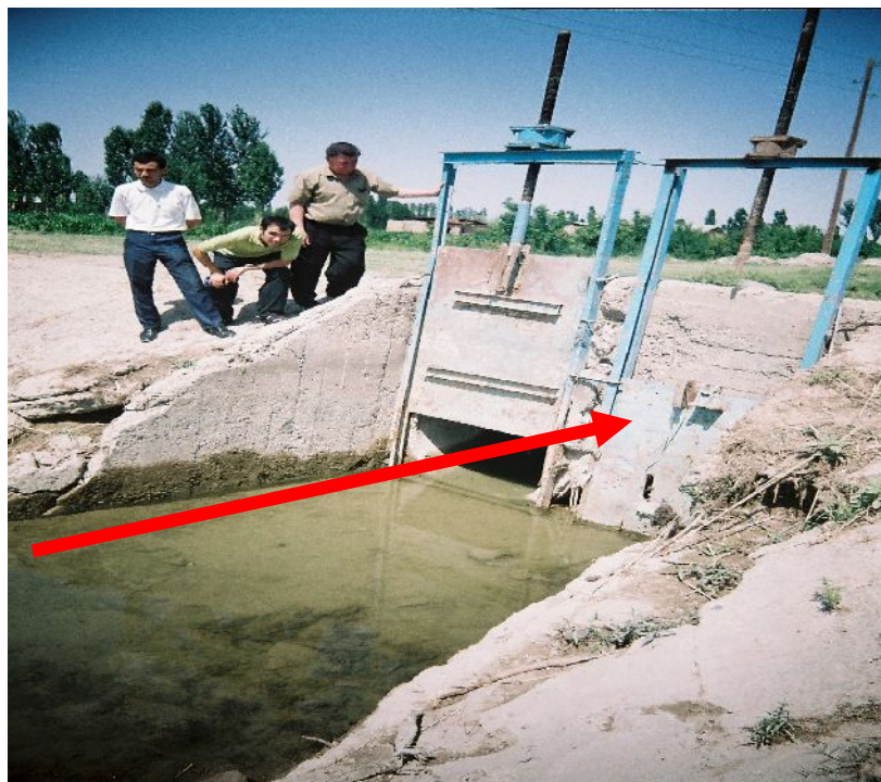
3- расм. Шурузак канали дарвозанинг ўнг шчити носоз.
