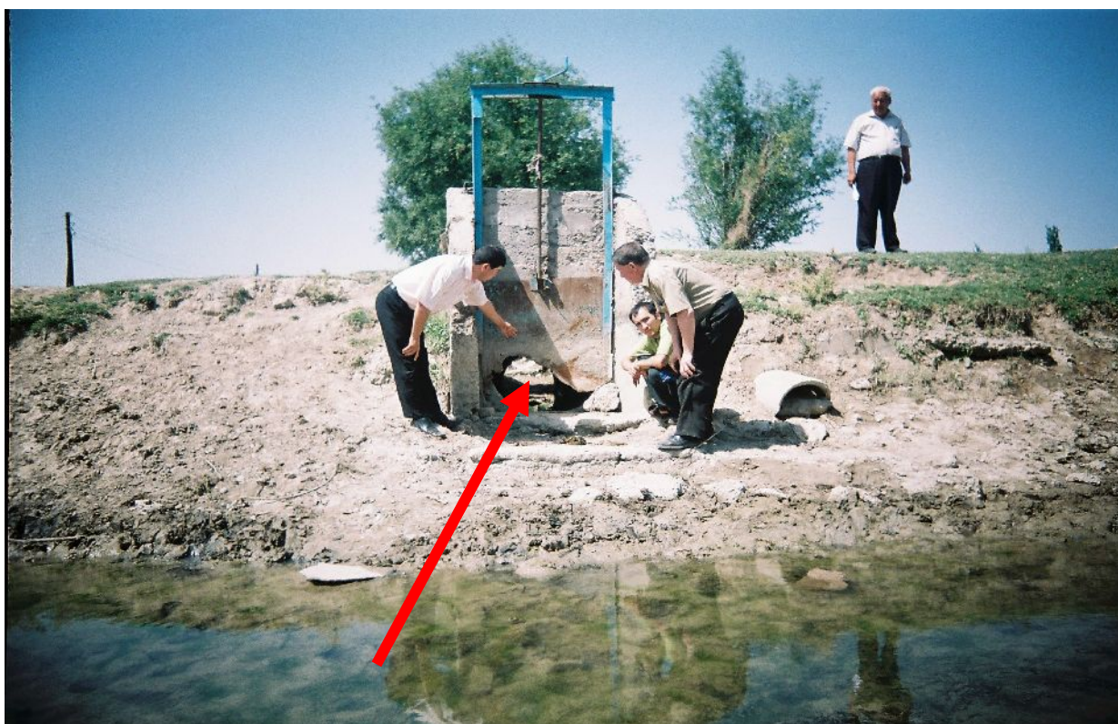
2-расм. Шўрузак канали дарвоза шчити чириган
