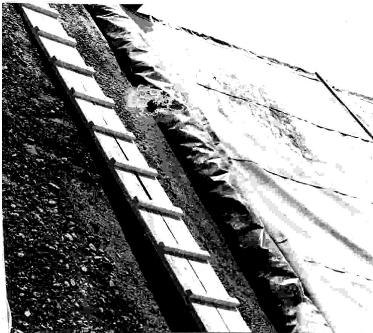
6-расм. Бетон конструкцияси сиртини ИТВП билан ёпиш
