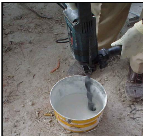
(a) Смешивание компонента А с помощью мешалки типа весла
