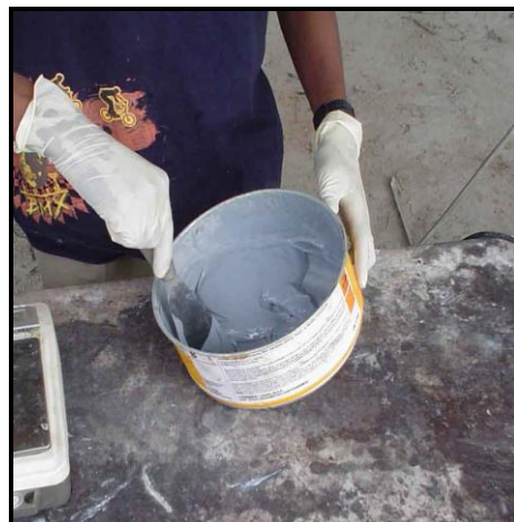
(b) Смешивание компонента В с помощью совком (scraper)
