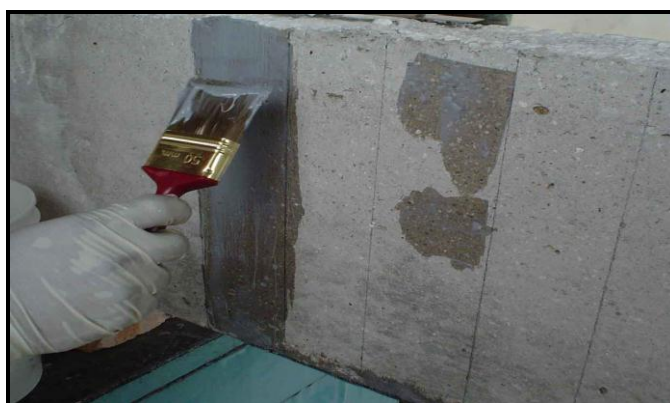
Рис. 2.10. Применение грунтовку эпоксидной смолой на намеченном месте
