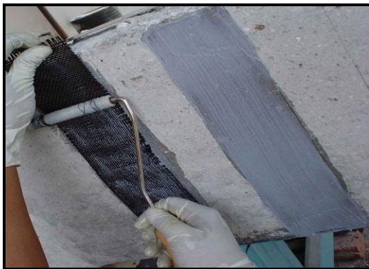
Рис. 2.11. Применение ребристого ролика согласно руководству волокна
