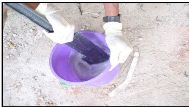
Рис. 2.8. Смешивание компонента А и В при помощи лопатки
