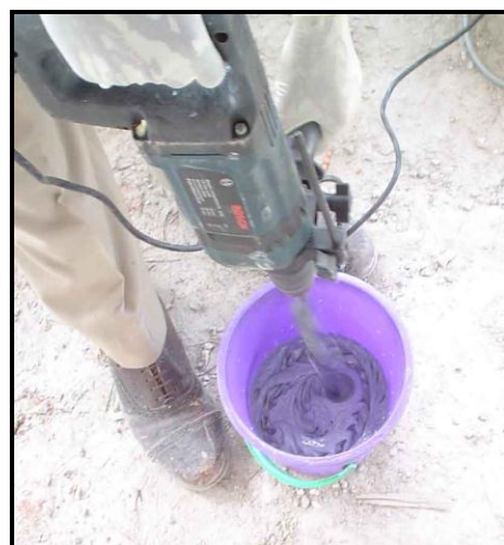
(d) Смешивание компонента А и В
