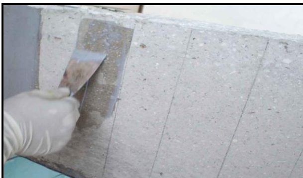
Рис. 2.9. Выравнивание поверхности и заполнения маленьких пор и раковин
