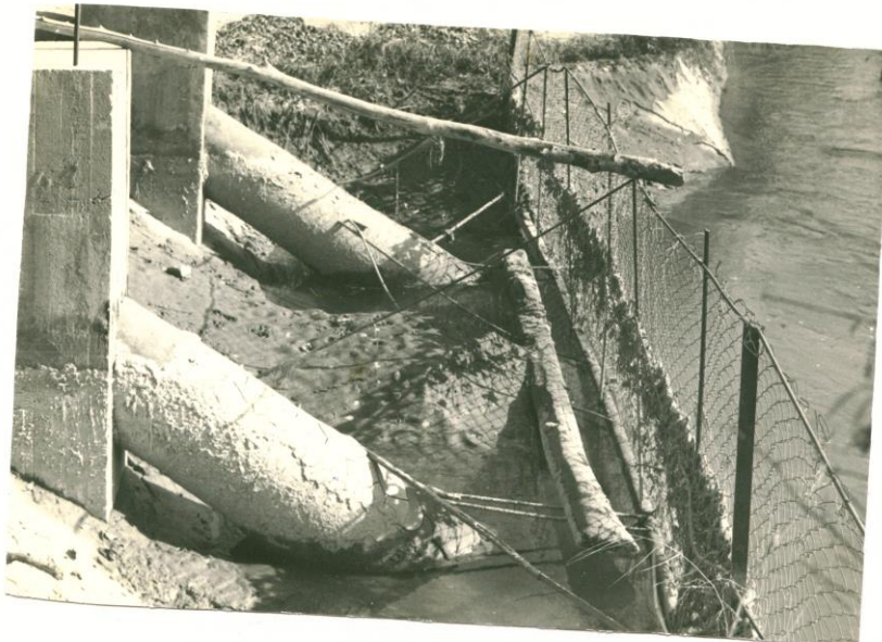
12.2-rasm. To'raqo'rg'on I (a) va II (b) nasos stansiyalarining suv qabul qilish bo'linmasidagi cho'kindilar
