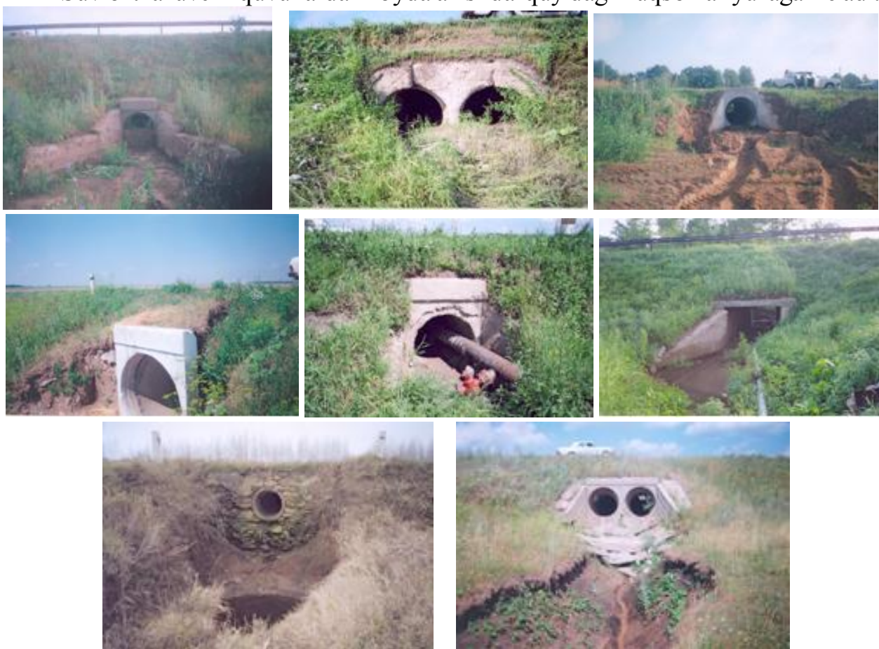
59-rasm. Suv o'tkazuvchi quvurlarni loyqa bosishi, o'simlik qatlamini buzilishi, ko'tarma yon bag'irlari eroziyasi, suvo'tkazuvchi quvurlardagi quvur o'tkazgichlar, suvo'tkazuvchi quvurni mustaxkamligini buzilishi, o'zan yuvilishi va jarlik hosil bo'lishi
