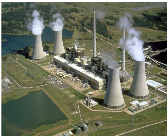
Issiqlik elektr stantsiyasi
